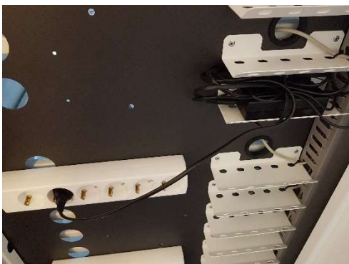
Rückseite mit Steckdosenleiste und Ablage für Ladegeräte
